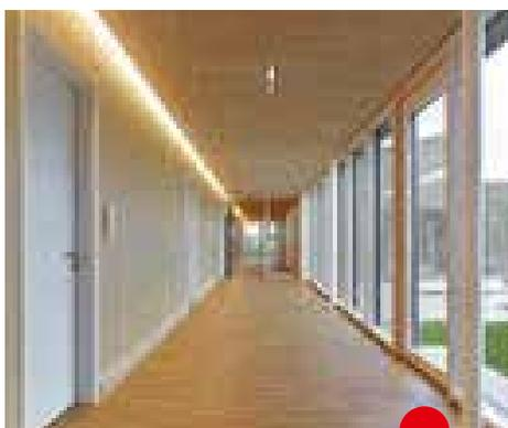
zur spielerischen Entfaltung. Flach geneigte Rampen verbinden die gestaffelten Niveaus der Kindergartenlandschaft. Die tragenden Wände bestehen aus Brettsperrholz und sind im Innenraum sichtbar. Auch die Decken sind aus Brettsperrholz gefertigt und abgehängt mit naturfarbenen Holzwoll-Akustikdecken. In allen Räumen – außer in den Sanitärbereichen – liegt ein durchgehender Eichenboden auf einem Heizestrich.
