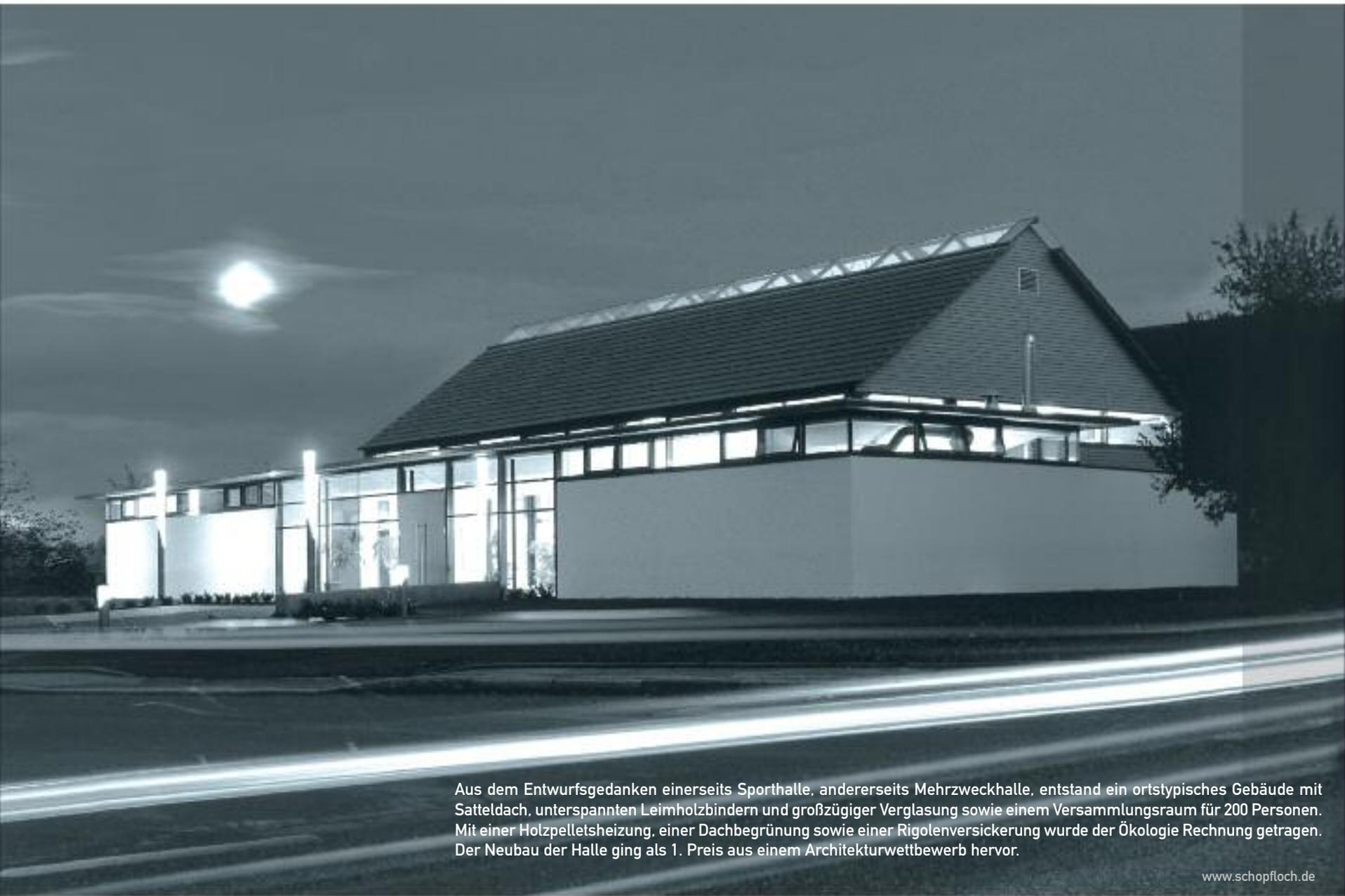
Aus dem Entwurfsgedanken einerseits Sporthalle, andererseits Mehrzweckhalle, entstand ein ortstypisches Gebäude mit Satteldach, unterspannten Leimholzbindern und großzügiger Verglasung sowie einem Versammlungsraum für 200 Personen. Mit einer Holzpelletsheizung, einer Dachbegrünung sowie einer Rigolenversickerung wurde der Ökologie Rechnung getragen. Der Neubau der Halle ging als 1. Preis aus einem Architekturwettbewerb hervor.
